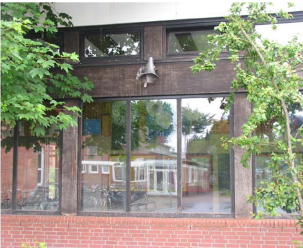
Witterungsschäden an der Fassade Pausenhalle
